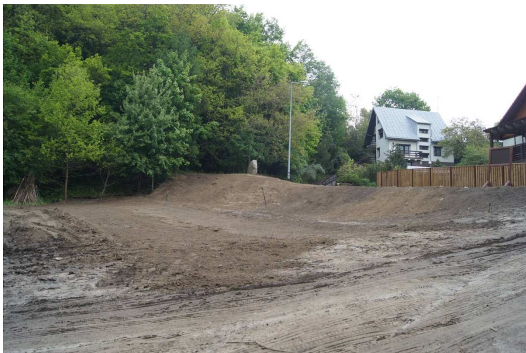
Fot. 11. Teren płatu nr 1 po zakończeniu pierwszego etap realizacji projektu (maj 2014 r.)
