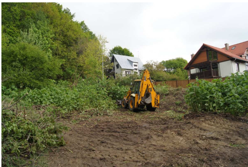
Fot. 3 i 4. Pierwszy etap realizacji projektu – usuwanie pędów rdestowca z płatu nr 1 przy użyciu ciężkiego sprzętu (maj 2014 r.).
