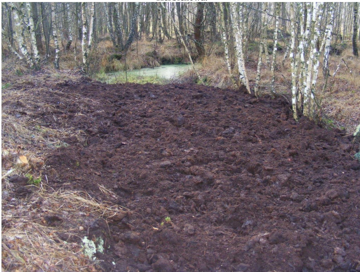
Rezerwat Czarne Bagno. Jedna z 15 wykonanych przegród ziemnych. 10.11.2011 r. Fot. M. Herbichowa.
