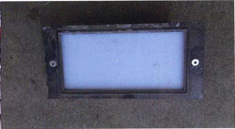
Oświetlenie LED wpuszczone we wnęki ścian betonowych basenów (szt.21 poz.3)
