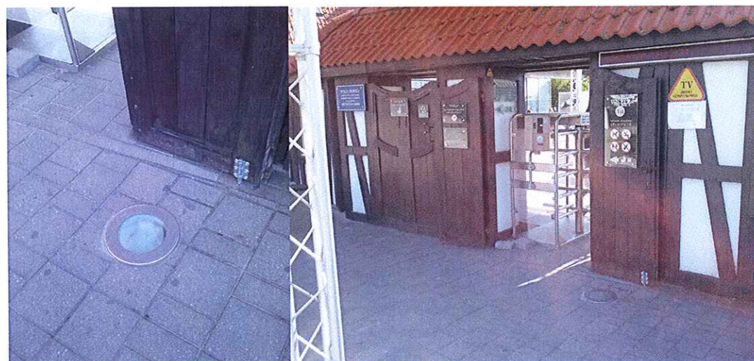
WYMIANA OPRAWY PODLOGOWEJ NA LED (szt.1 poz.7)
