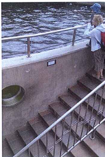
Oświetlenie LED wpuszczone we wnęki ścian betonowych basenów (szt.21 poz.3)
