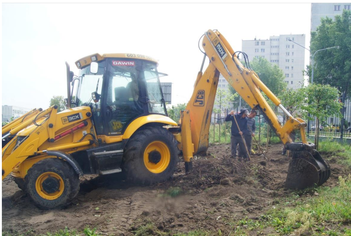
Fot. 4. Usuwanie podziemnych kłączy rdestowca ostrokończystego
