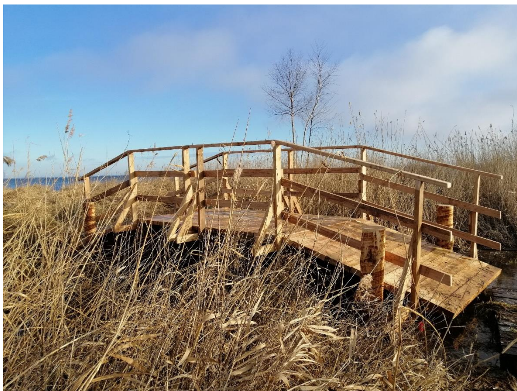
Mostki drewniane na rowach (fot 5-6)
