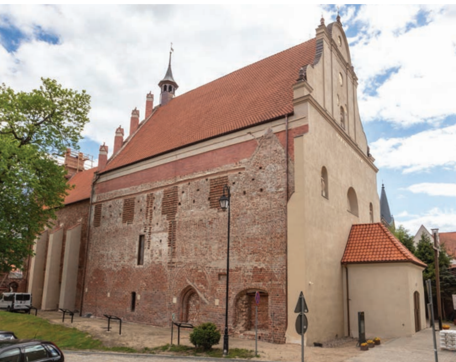
Kościół franciszkanów pw. św. Andrzeja Apostoła w Barczewie – elewacja północna, stan przed konserwacją i po konserwacji.
